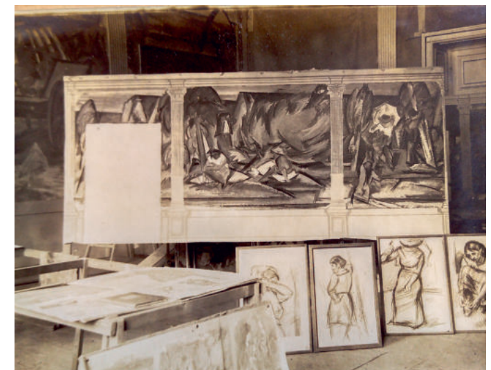
Während der Arbeiten im Treppenhaus (vor 1915)
