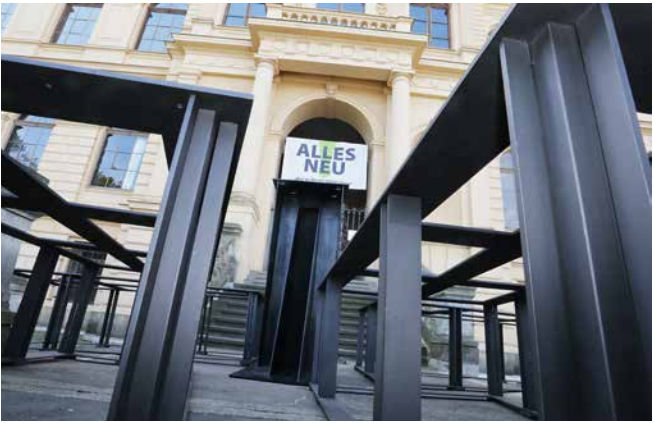
Alles neu: Das Lindenau-Museum wird für die bevorstehenden Sanierungsarbeiten geräumt.
